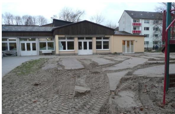
Die Sandkiste wurde mit einem Mini-Bagger abgebaut.
