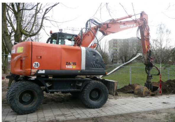
Der große Bagger bereitet die Baustraße vor.
