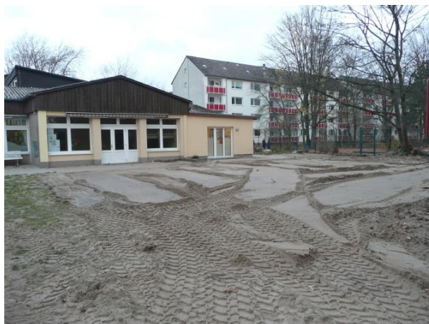
Der Bereich für den Anbau im November 2018
